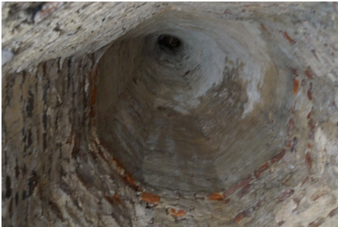
Rys. nr 6. Stożkowe zwieńczenie wieży od wewnątrz – stan techniczny średni.
