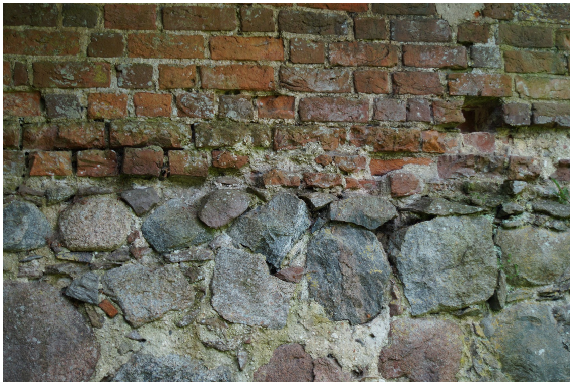
Rys. nr 3. Mur podstawy wieży w średnim stanie technicznym.
