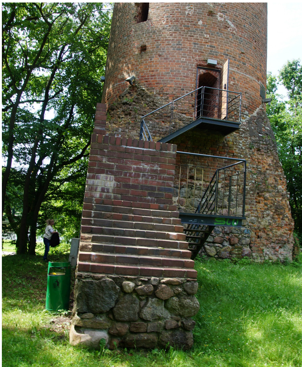
Rys. nr 8. Schody zewnętrzne – widok ogólny – stan techniczny średni.
