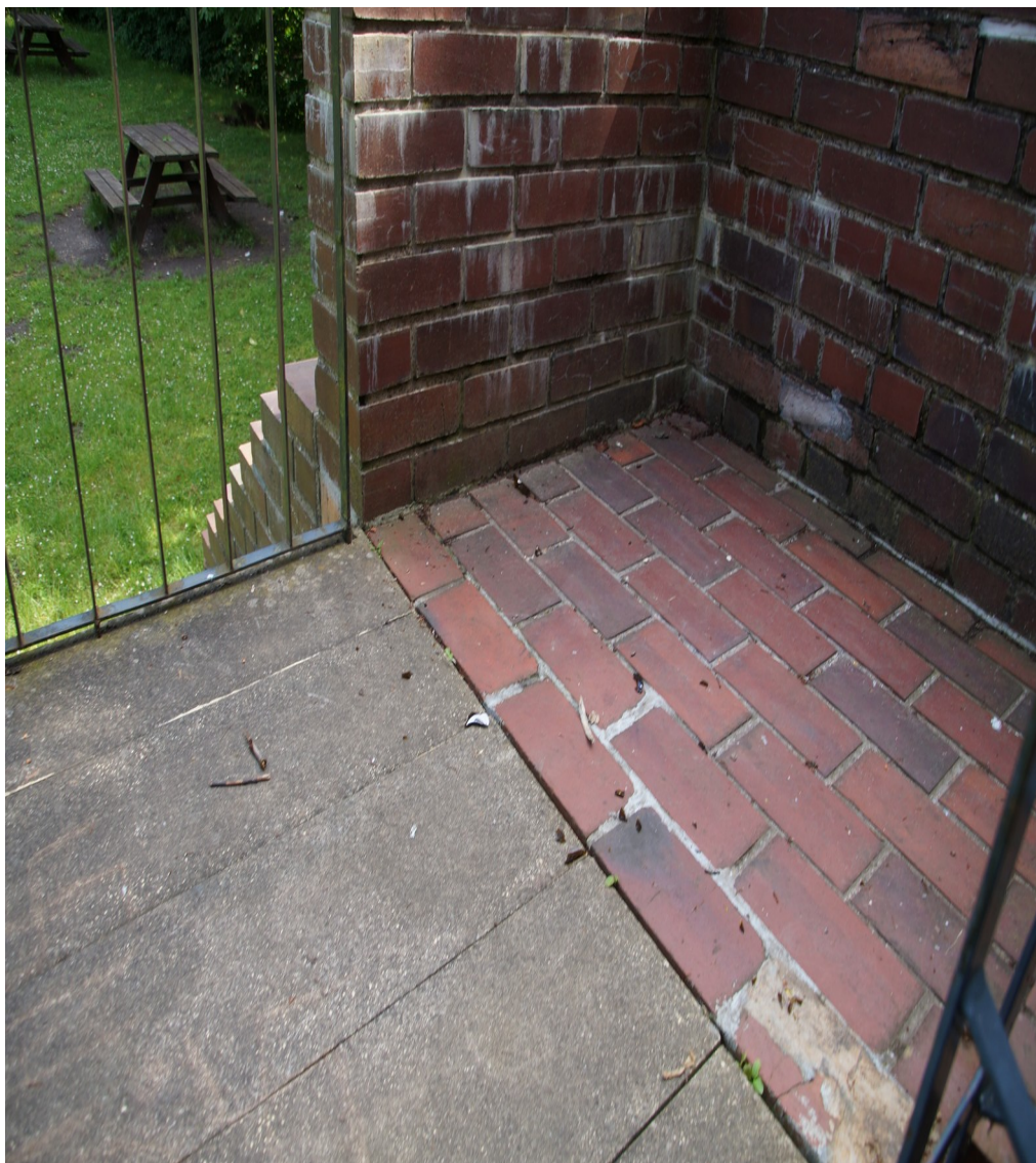
Rys. nr 9. Schody zewnętrzne: współczesne wymurowanie z cegły klinkierowej z widocznymi wysoleniami i uszkodzeniami, płyty schodowe betonowe do remontu – stan techniczny średni.
