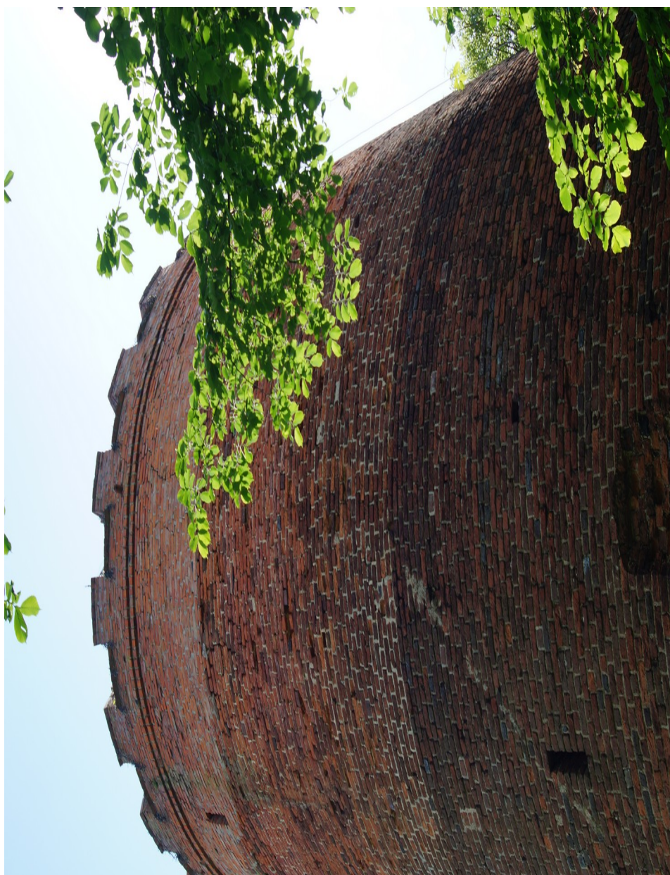
Rys. nr 4. Mur zewnętrzny z widocznymi przemurowaniami współczesnymi.
